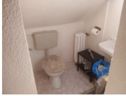
WC im Dachboden
