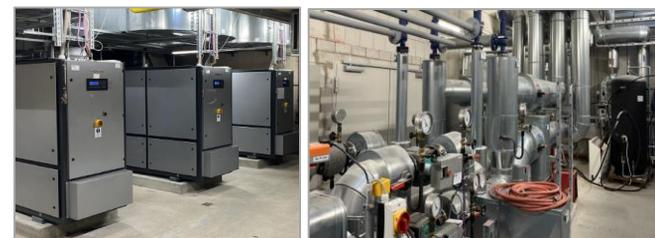
Drei Blockheizkraftwerke VISSMANN VITOBLOCK 200; Anschlüsse für eine geplante Erweiterung auf 4 Blöcke bereits vorhanden.
