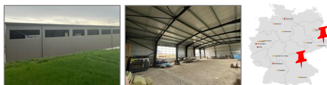
Neue Produktionshalle Hohenburg (aktuell noch nicht vollständig fertig gestellt). Hallenfläche ca. 700qm; Grundstück rd. 5000qm).
