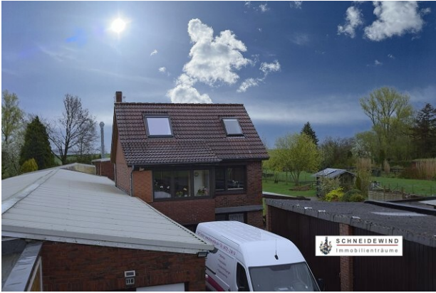
k-38 Blick auf das Hinterhaus
