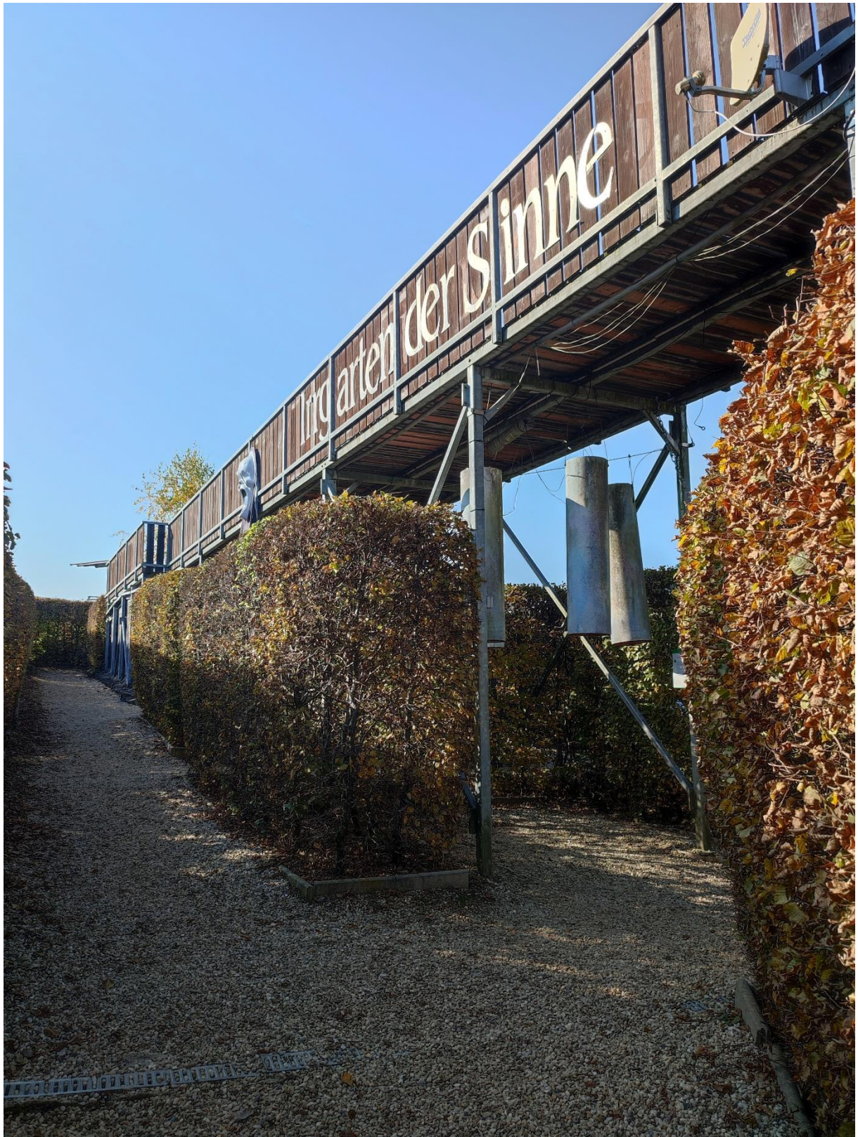
Brücke von unten
